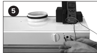
Mittaa jännite navoista – ja S, säädä nopeus 2 potentiometriltä 2, jne.
